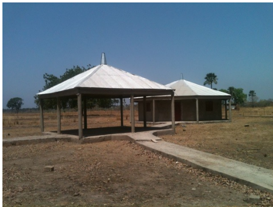
Chantier de Wassadou
