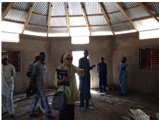
Visite de chantier à Wassadou
