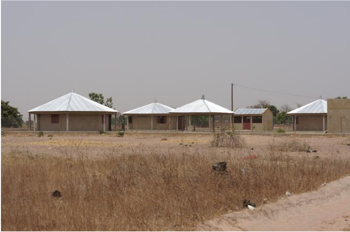
Le chantier de l'école maternelle de Diagane Barka
