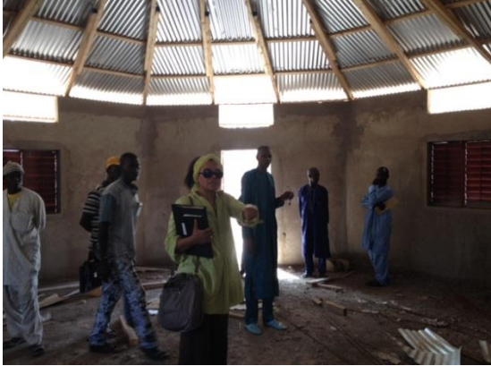
Visite de chantier à Wassadou
