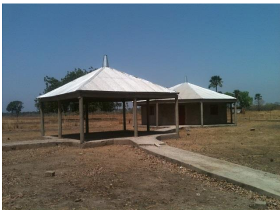
Chantier de Wassadou
